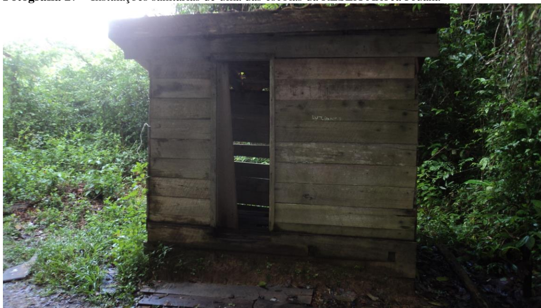
Fotografia 27 – Instalações sanitárias de uma das escolas da RESEX Arióca Pruanã
