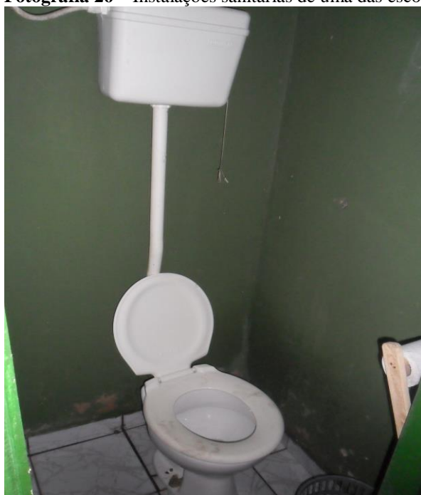
Fotografia 26 – Instalações sanitárias de uma das escolas da RESEX Arióca Pruanã
